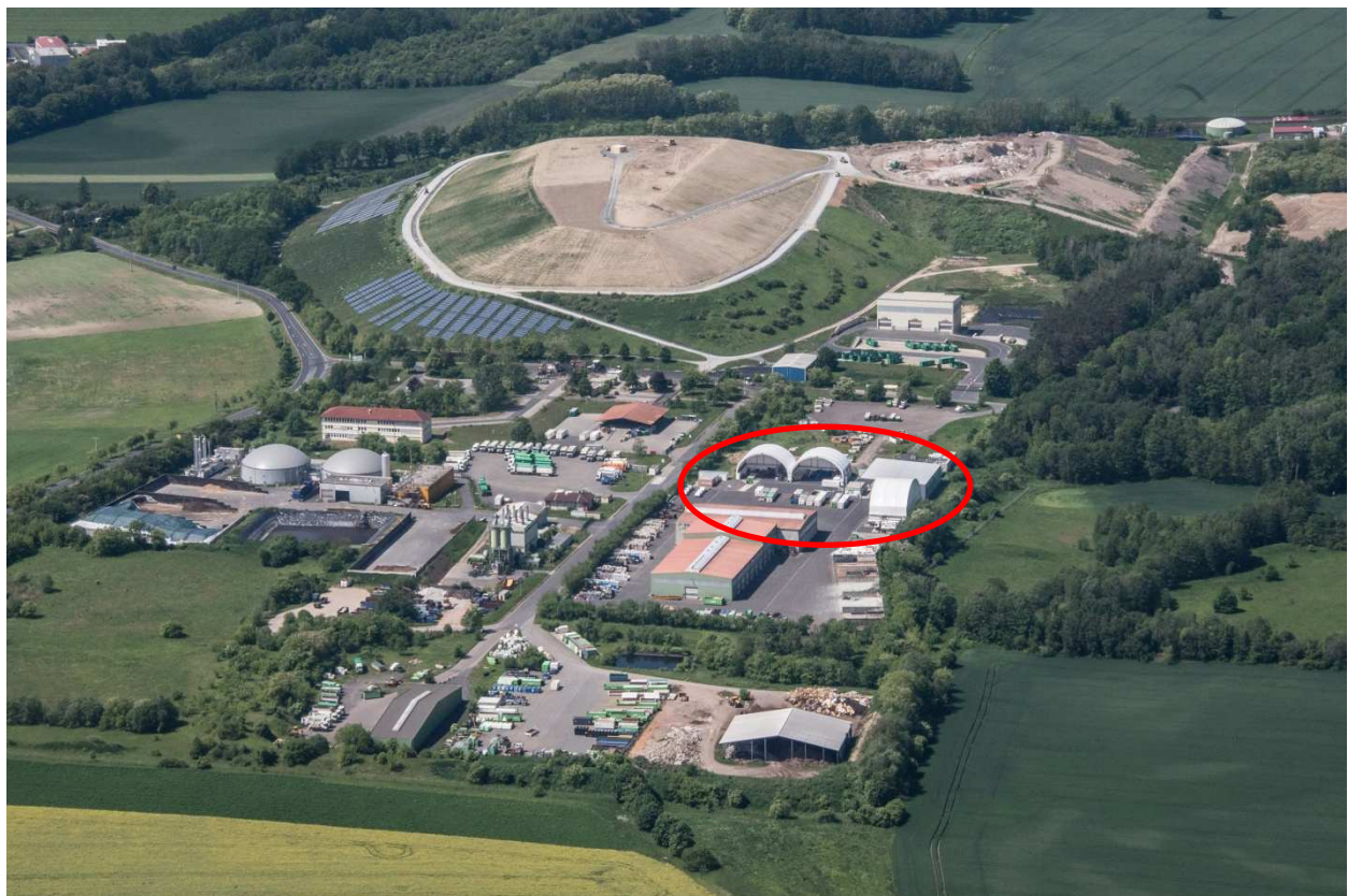
Sonderabfallzwischenlager Gröbern, Luftbild 2019
